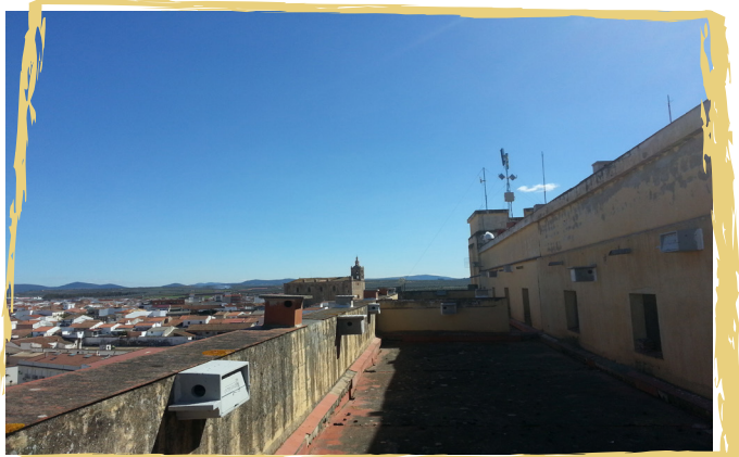
5. Instalación de cajas nido para cernícalos primilla en antiguos silos cerealistas. ©Javi L.
